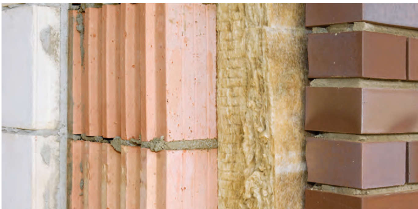
Mehrschalige Außenwandkonstruktion
