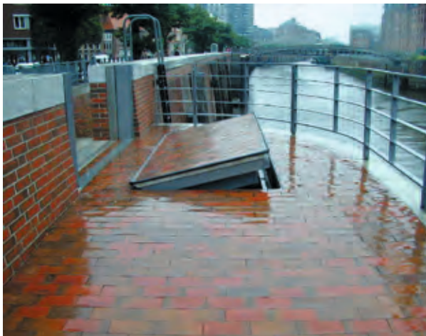
Integrierte Hochwasserschutzklappe
