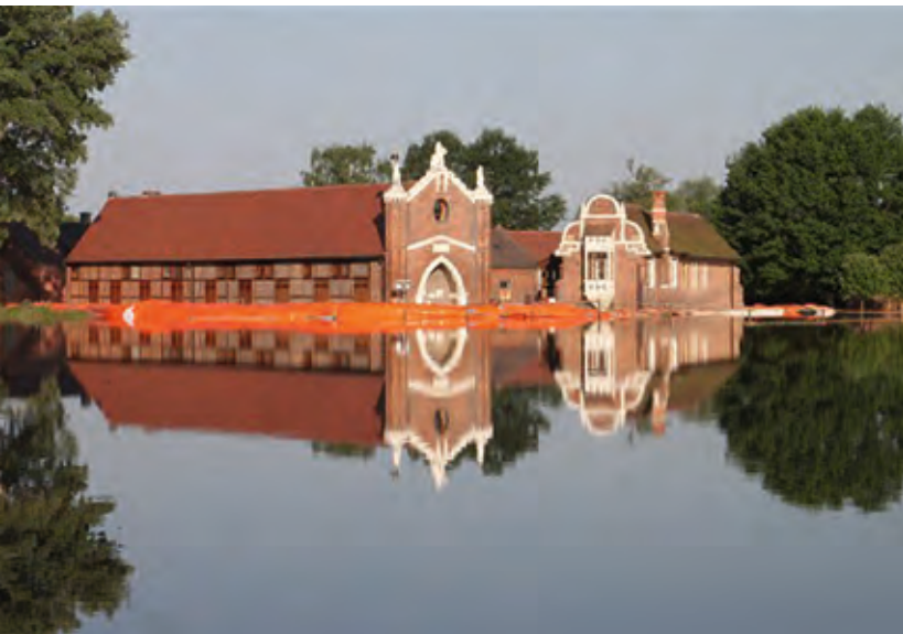
Hochwasserschutz mit mobilem wassergefülltem Schlauchsystem
