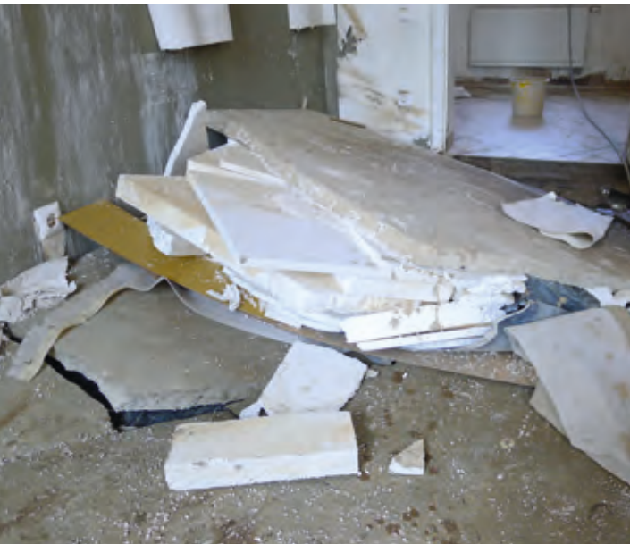
Aufgeschwommener schwimmend verlegter Zementestrich
