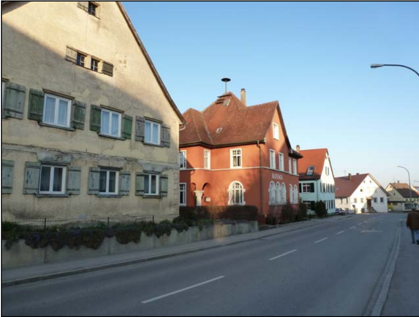
Ehemaliges Rathaus (rotes Gebäude)
