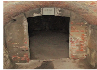
Kellergewölbe unter der Altstadt
